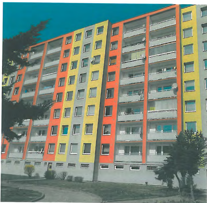
Oprava objektu v Teplicích, ulice Edisonova 1641 - 1642
