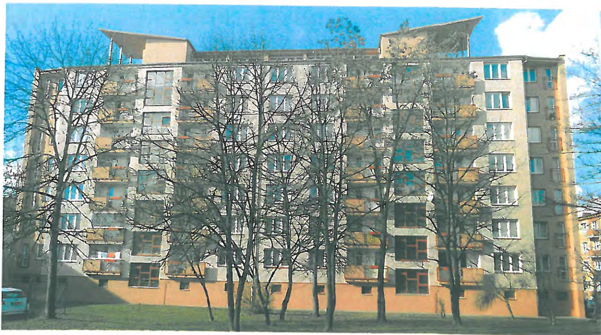
Příklad realizace provedení tzv. druhé etapy objektů V Teplicích, ulice Duchcovská 2382 - 2383
